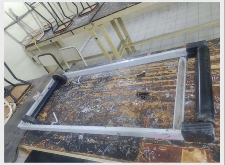
Armado de partes de la estructura metálica.
