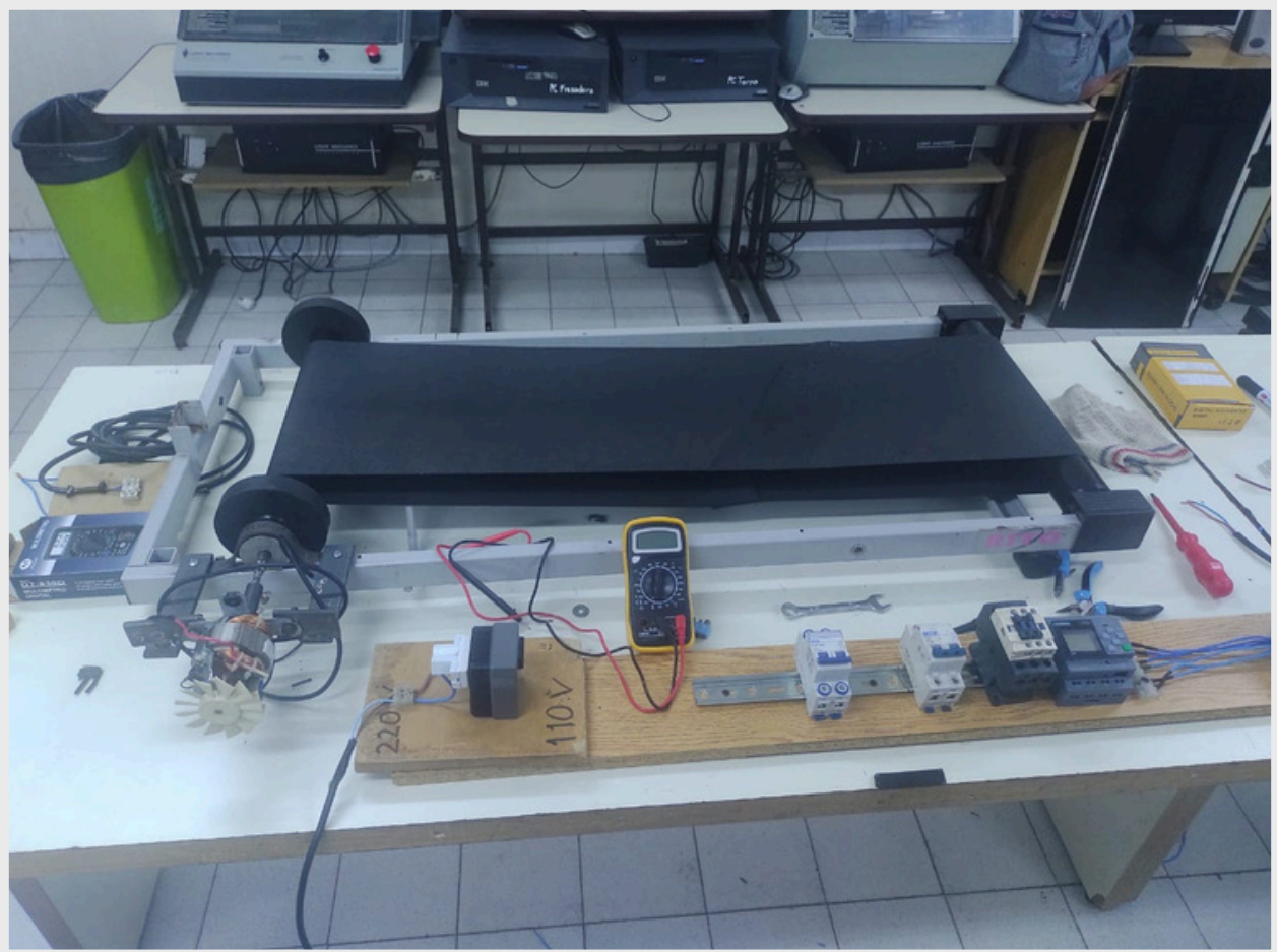
Armado de instalación eléctrica con transformador, llaves térmicas, contactor y PLC.
